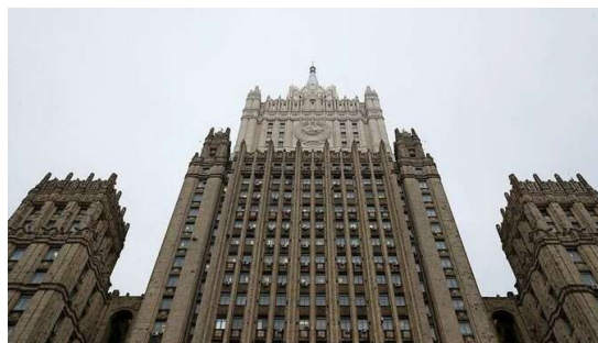
Hình 2: Tòa nhà Bộ Ngoại giao Nga ở Thủ đô Moscow
